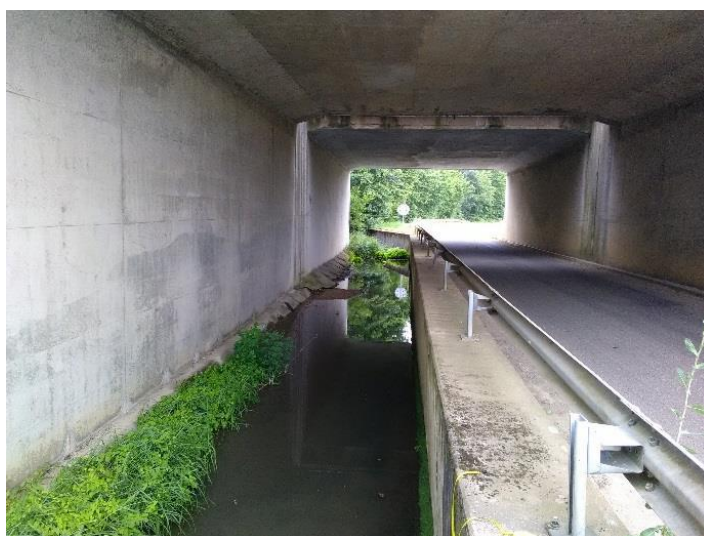
PHOTOGRAPHIE 1 : LA GRAVAISE SOUS LE PONT DE L’A6 AVANT TRAVAUX (CREDIT PHOTO : EPTB SAONE-ET-DOUBS)
