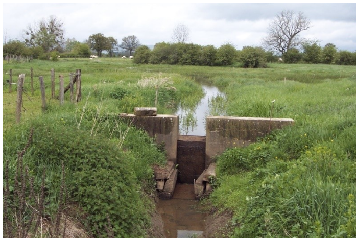
OUVRAGE HYDRAULIQUE DE LA ZONE HUMIDE DE L'ORME, GERE PAR L'AAPPMA D'AUTUN
